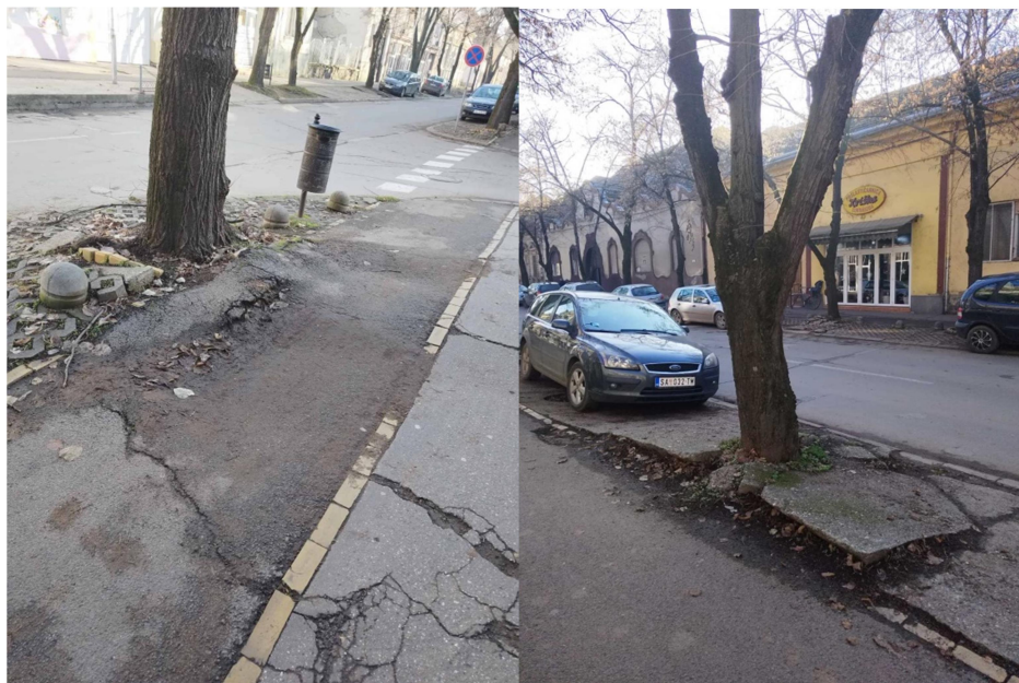
Slika 1. - Postojeće stanje – oštećenja trotoara izazvana korenovim sistemom postojećih stabala
